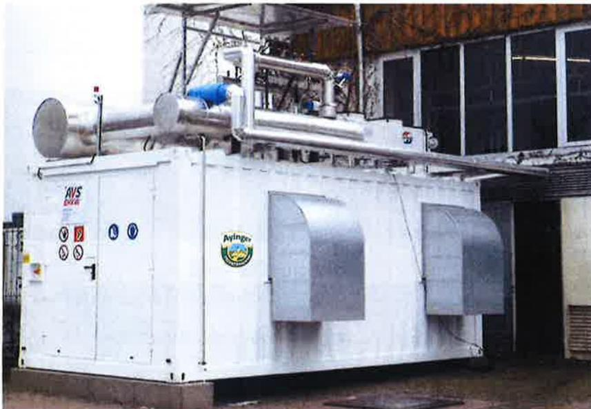
Ende 2012 wurde ein neues Blockheizkraftwerk mit 200 kW elektrischer Leistung in Betrieb genommen. Seitdem erzeugen wir den größeren Teil des benötigten Stroms selbst und geben insbesondere nachts Strom ins Netz ab.
